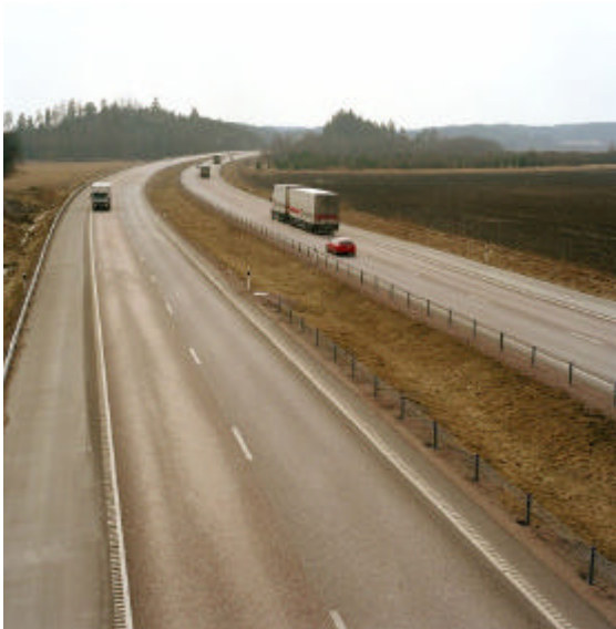
E4-an norr om Nyköping byggd med Hyttsand på mark med dålig bärlighet.
