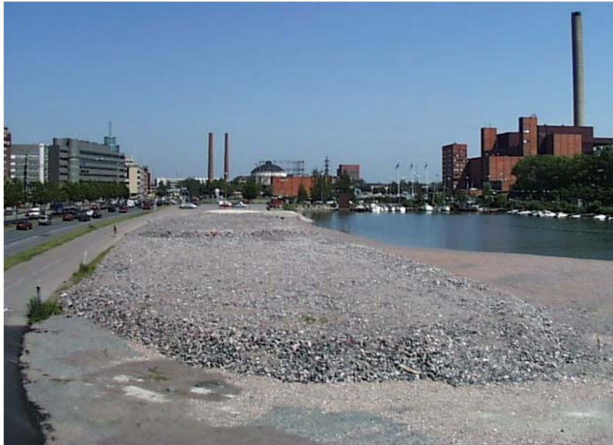
Sörnäs strand, förbelastningsbank
