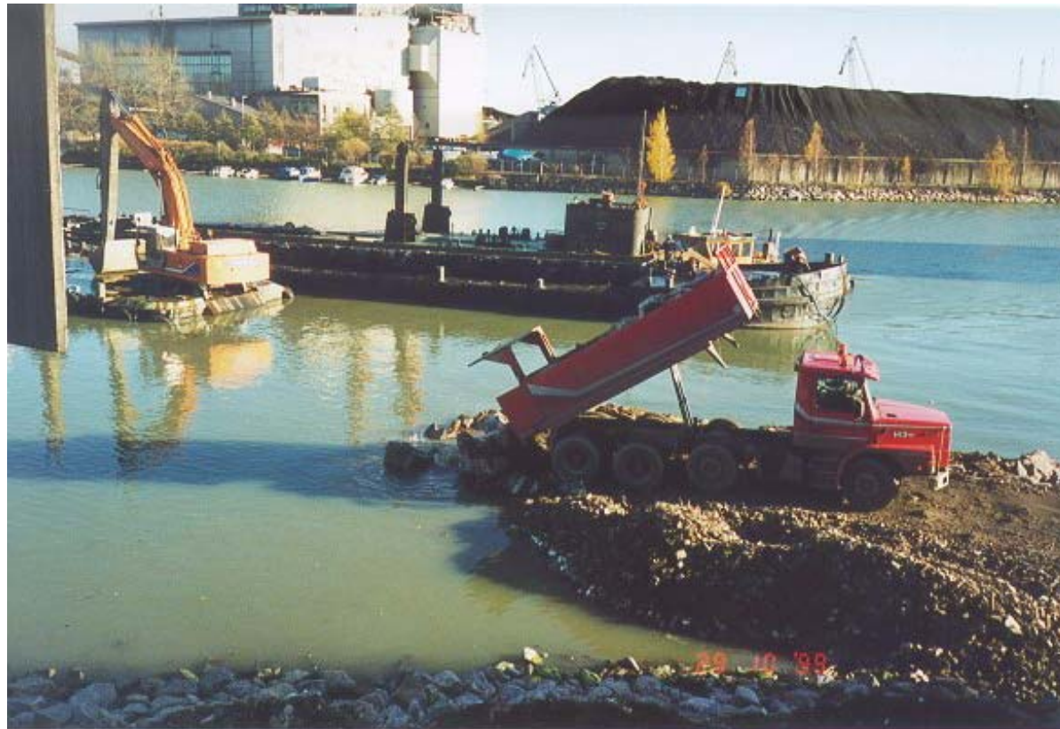
Sörnäs strand, arbetet på gång
