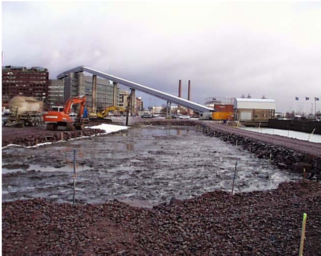
Sörnäs strand, arbetet på gång
