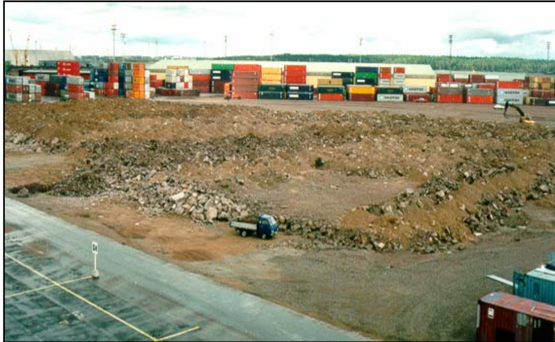
Färdig masstabilisering med överlast
