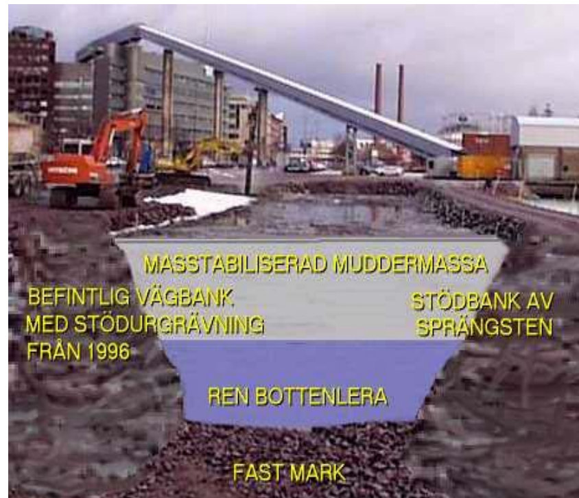
Strandkonstruktion för Sörnäs strand.
