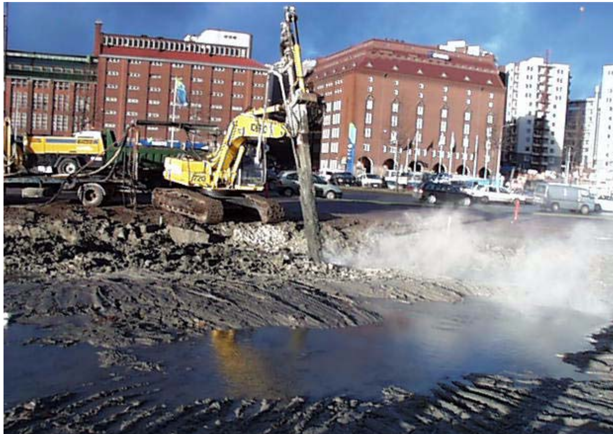
Sörnäs strand, arbetet på gång
