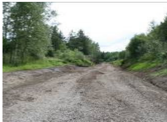
Efter stabilisering och överbyggnad
