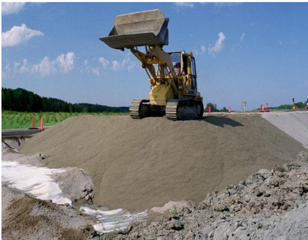
Figur 12. Hyttsandsutläggning på riksväg 57 vid Gnesta.
